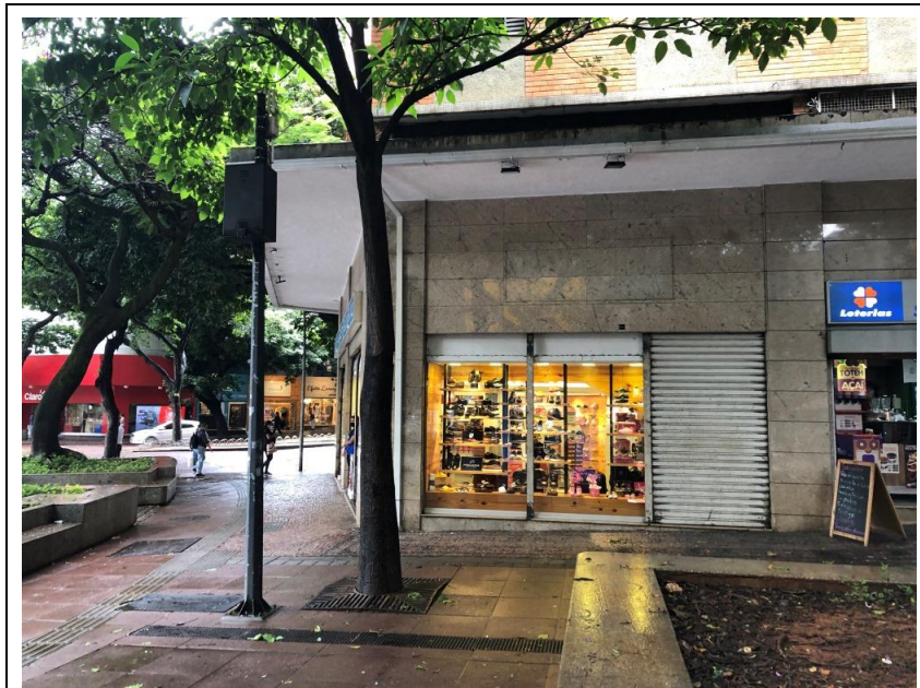
Fachada – Frente para Rua Pernambuco
