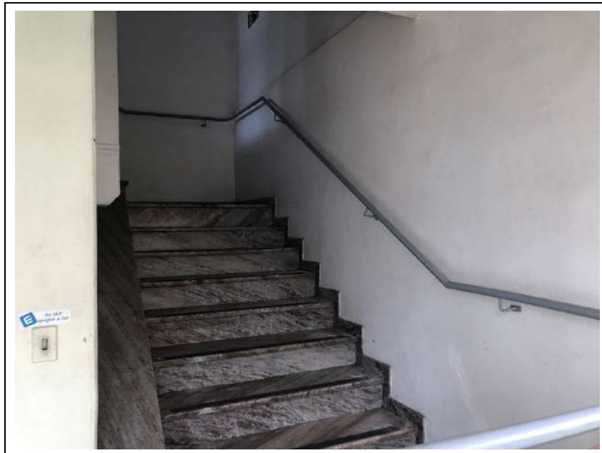
Vista Interna prédio – escada acesso ao 6º andar
