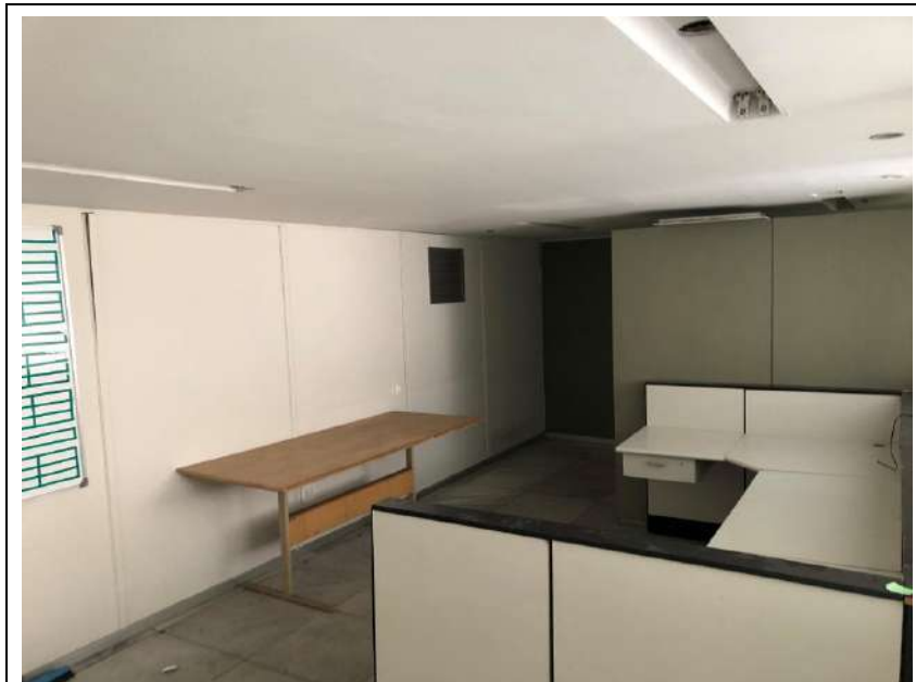
Vista Interna prédio – 5º andar
