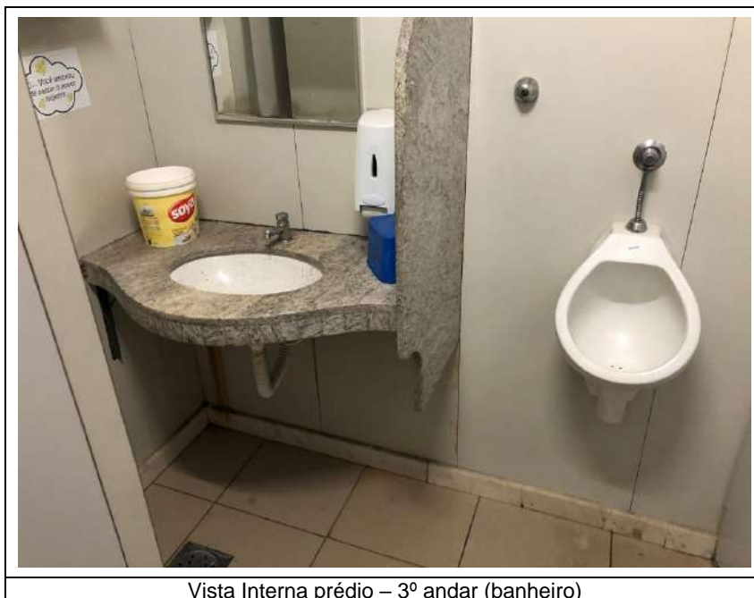
Vista Interna prédio – 3º andar
