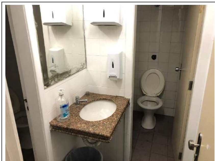
Vista Interna prédio – 3º andar (banheiro)
