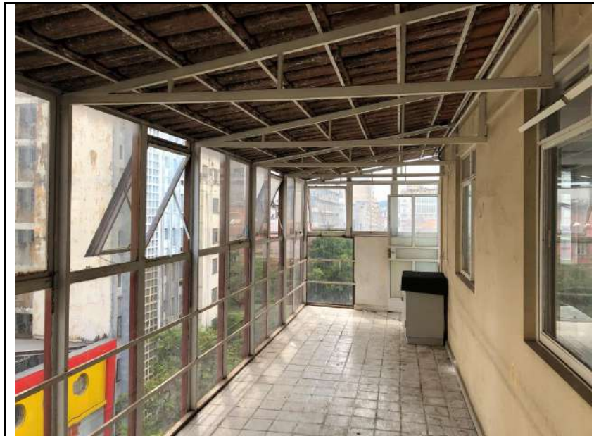
Vista Interna prédio – 6º andar
