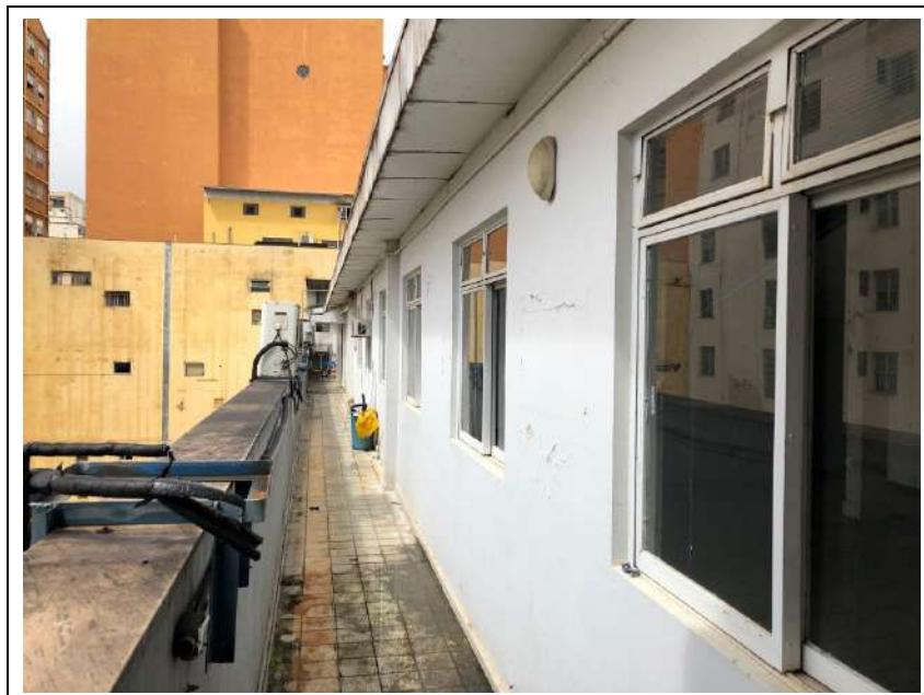
Vista Interna prédio – 6º andar
