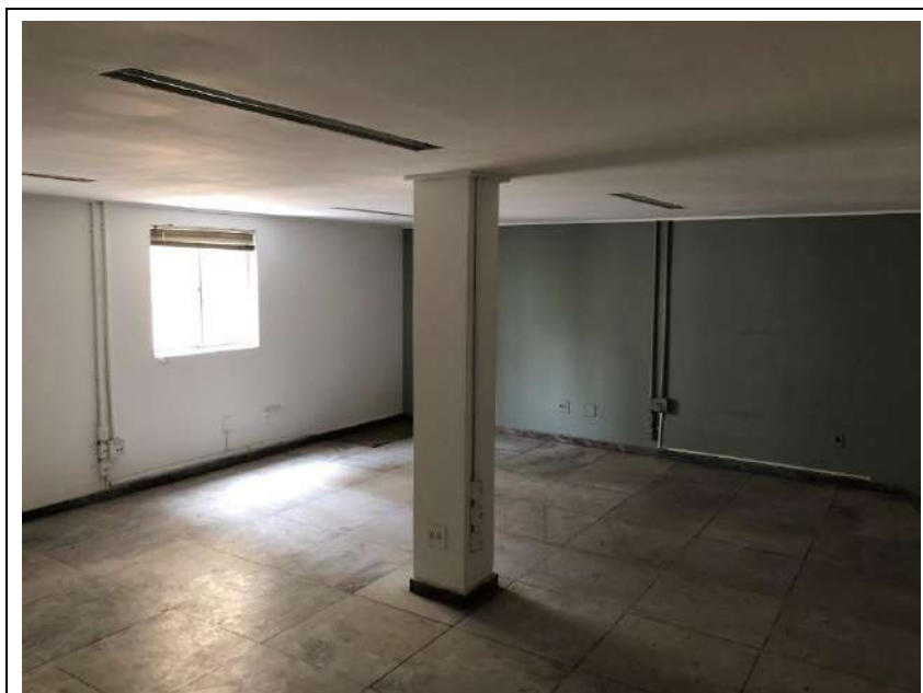
Vista Interna prédio – 4º andar
